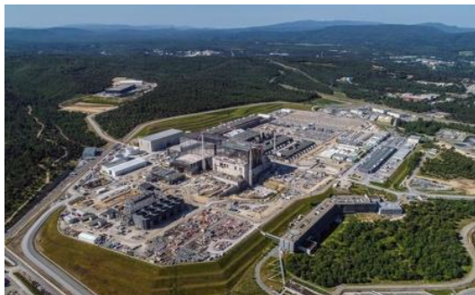
Bouw werelds grootste kernfusiecentrale ITER.
