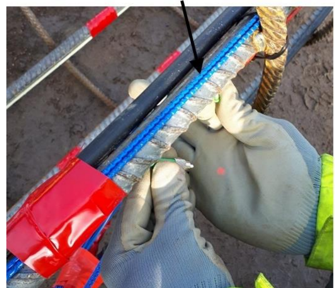
2 BOFDA optische vezelkabels Diameter 3.2 mm
