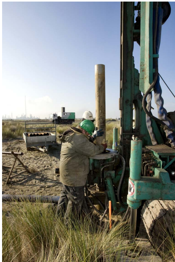
Aanleg elektrische infrastructuur aan de Maasvlakte met gestuurde boring tot 40 m -NAP.
