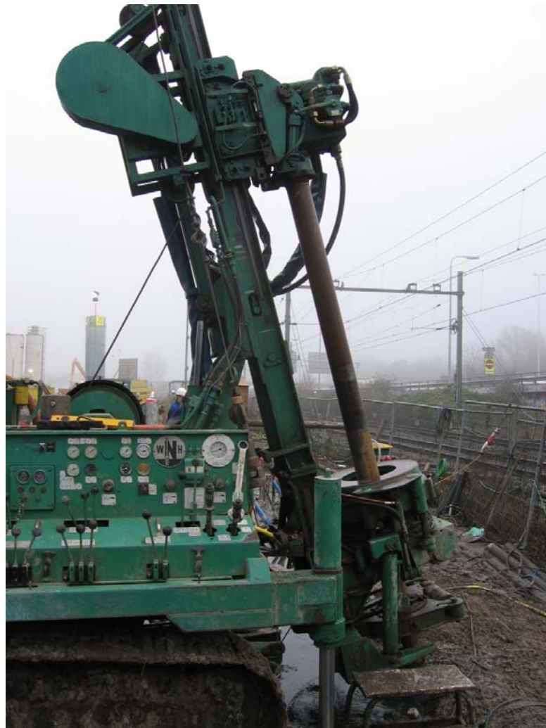
Kernboren bij bodemverbetering voor boortunnel metro Randstadrail, St. Franciscus Driehoek Rotterdam.
