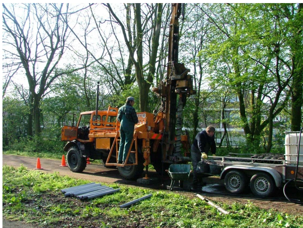
Geotechnisch onderzoek in polder Zestienhoven (kwel-locatie).
