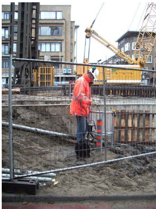
Bewaking belendingen bij grondvervormingen d.m.v. inclinometingen, aanleg RandstadRail, Statenweg Rotterdam.
