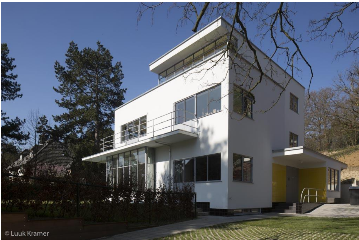
Villa te Overveen Molenaar & Co architecten 2016, bewerking van Huis De Bruyn te Schiedam, Brinkman & Van der Vlugt architecten 1930
