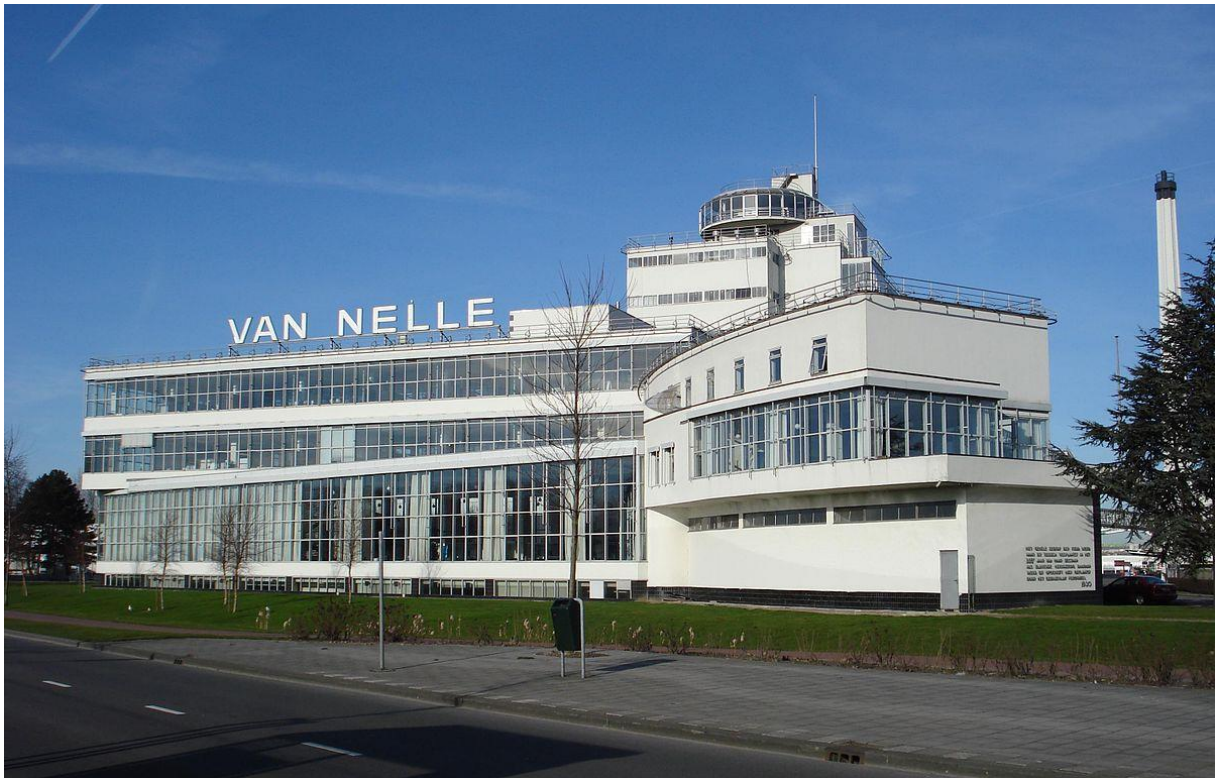
Kantoor Van Nellefabriek Rotterdam Overschie Brinkman & Van der Vlugt architecten 1929, herbestemming Molenaar & Co architecten 2005
