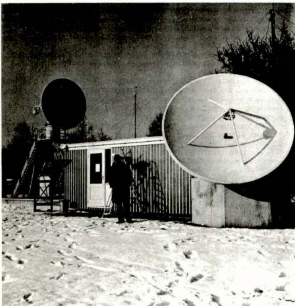
Fig. 3. Het grondstation voor de ontvangst van de ATS-6 satelliet van de Technische Hogeschool te Eindhoven.
