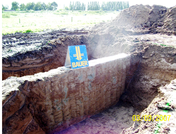
Kwelscherm in dijklichaam
