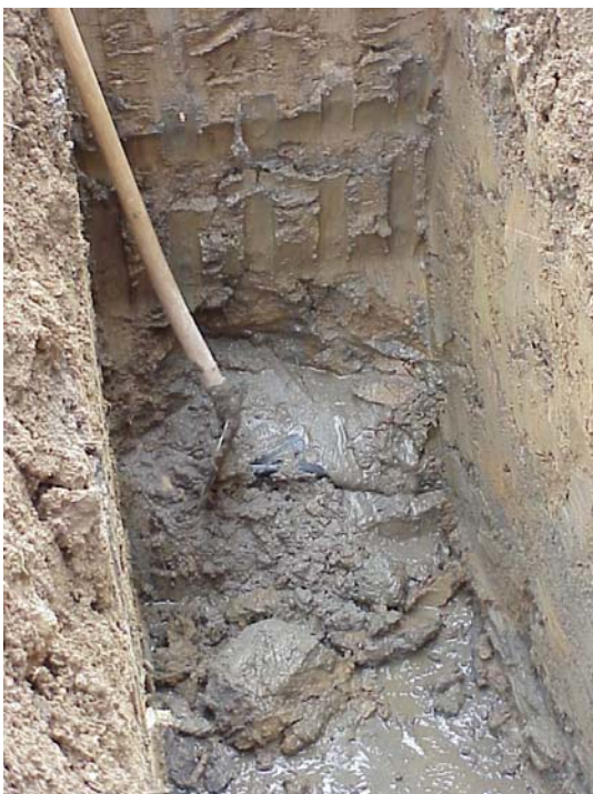
Foto's b5.27 en b5.28 Uitstromend water en grond na ontgraven [Arcadis]
