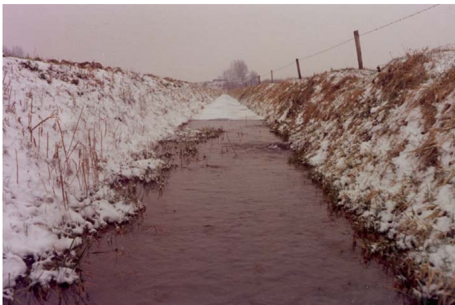
Foto b5.2 Strooming zichtbaar in de sloot aan de binnenteen van de waaldijk te Herwijenen, tijdens vorstperiode. [RWS-DWW 199/24]
