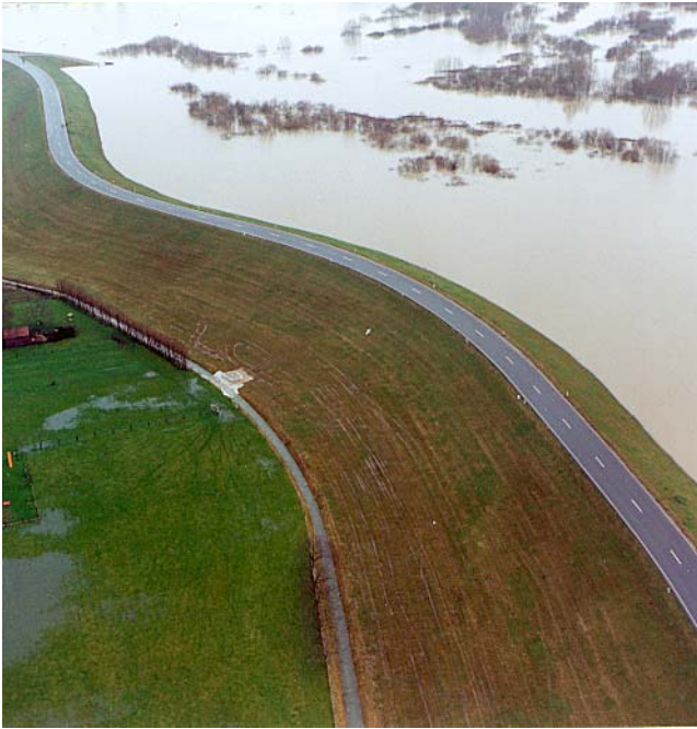
Foto b5.9 Rechteroever Pannerdensch Kanaal (km 868), uittredend water tijdens hoogwater op 27-12-1993. [AGI multimedia nr. 8274.57]
