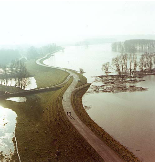
Foto b5.10 Linkeroever Waal (km 881, Ooipolder, Groenlanden, Dijk van Groenlanden naar Tiengeboden), ondergestroomd achterland ten gevolge van kwel. [AGI multimedia nr. 8176.25]
