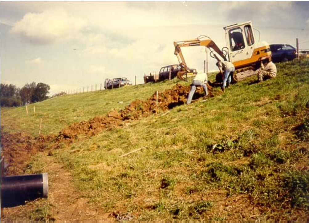
Foto b5.19 Opengraven van het hiervoor genoemde door muskusratten gemaakte gangenstelsel. [Provincie Zuid Holland]
