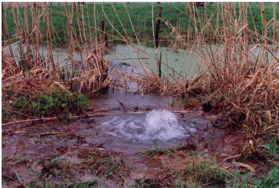
Foto b5.1 Waal, Recheroever te Heesselt (DP 126) tijdens hoogwater 1988. Schoon water spuit achter de dijk boven het maaiveld uit. [RWS-DWW 470/20]
