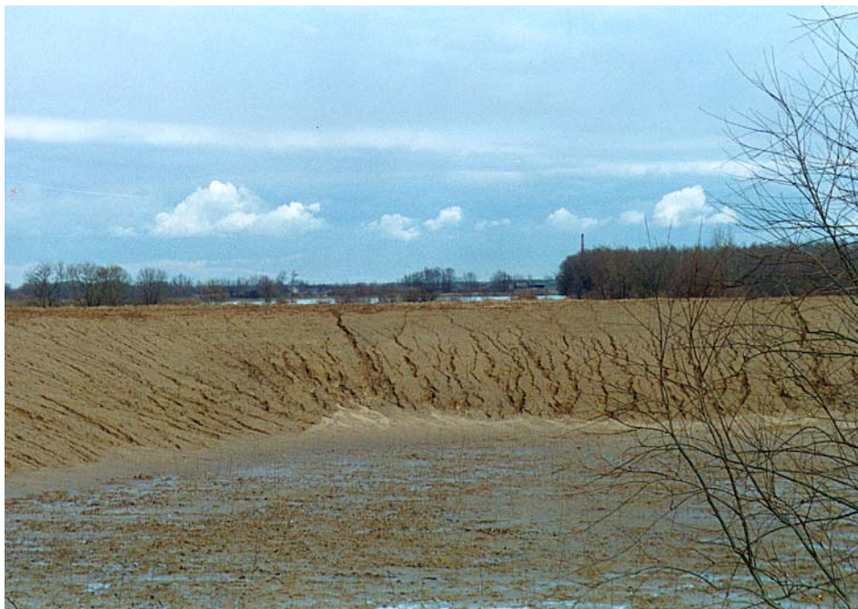
Foto b5.14 Dijk met geërodeerd binnentalud tijdens het hoogwater van 1995, Rijswijk, Afgedamde Maas, Nieuwendijk. [RWS/DWW 908/23]
