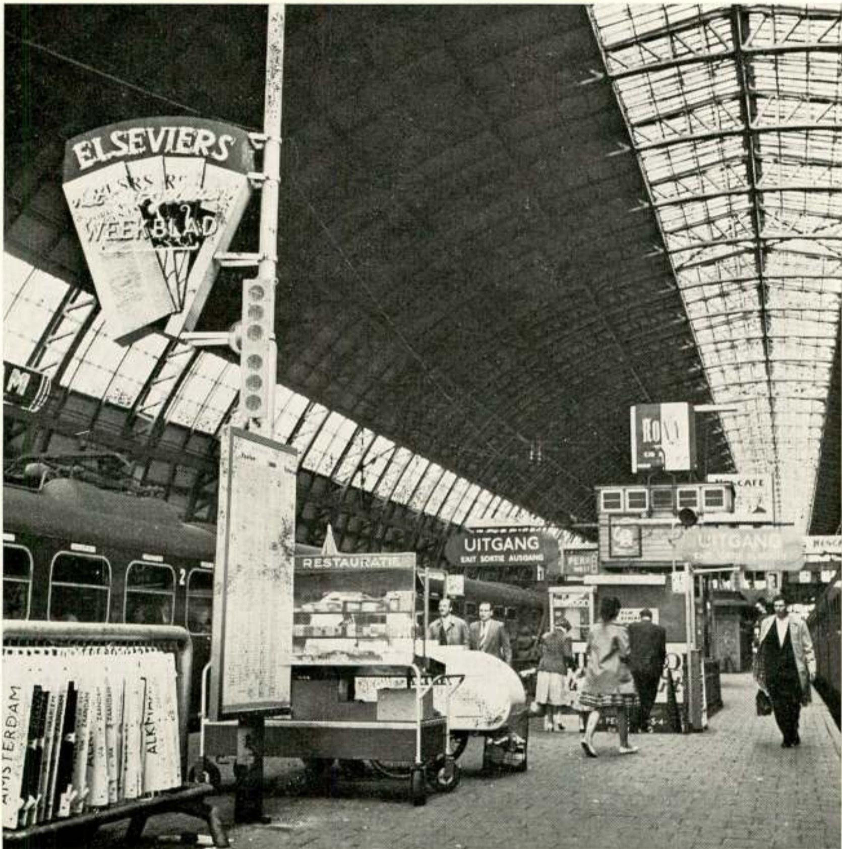
De geluidszuilen op het Amsterdams Centraal Station werden aan de ter plaatse bestaande masten bevestigd.
