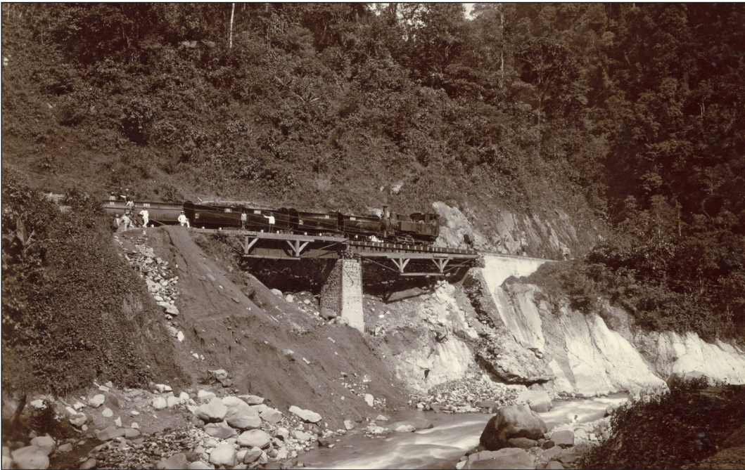
In het verre van vlakke Sumatra waren tandradstoomlocomotieven nodig om de Ombilinkolen naar de kust in Padang te brengen. De laatste werden in de jaren zestig gekocht. West-Sumatra, ca 1902. Foto: Rijksmuseum.
