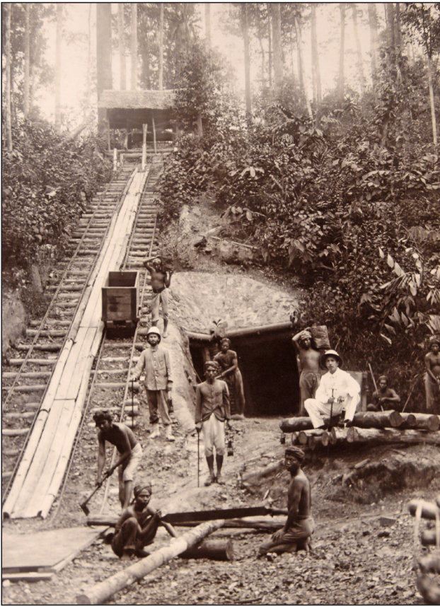
Om de hoogteverschillen in het mijnbedrijf te overwinnen werden op veel mijnbedrijven zogenaamde 'remhellingen' gebruikt, waarbij volle en lege wagens elkaar min of meer in evenwicht hielden. Op 4 september 1902 werd de remhelling naar de mijn Hoffnung op het eiland Poeloe Laoet geopend.
