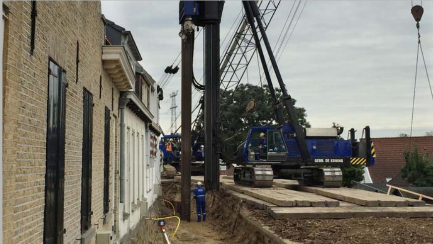
21 september 2017 | Drukken van stalen damwand KIVI
