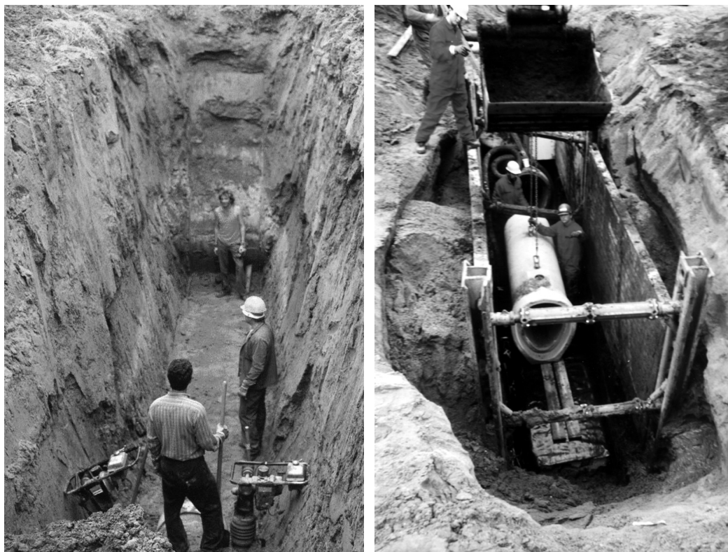
Figuur 6.55 Rioolsleuf zonder en met [VPB] sleufbekisting
