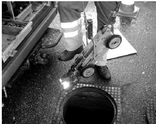
Figuur 7.7 Visuele inspectie van het riool met behulp van een rijdende tv-camera
