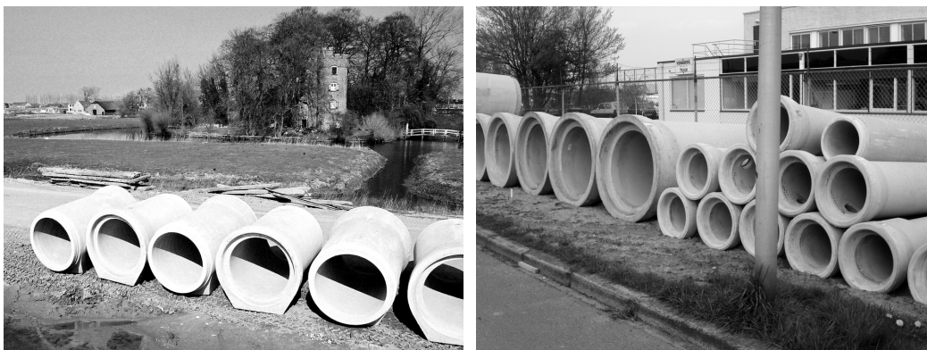
Figuur 6.3 Betonnen buizen met vlakke voet [Betonplaza] en ronde betonnen rioolbuizen met mof-en spie verbinding
