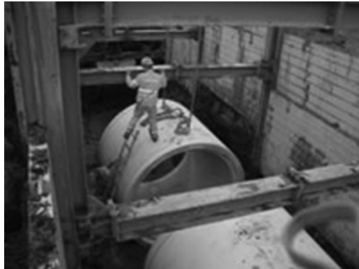
Figuur 6.56 Sleufbekisting m.b.v. stalen damwand (Syncera) en een moderne vorm van een "Berliner wand" (Euro Verbau)
