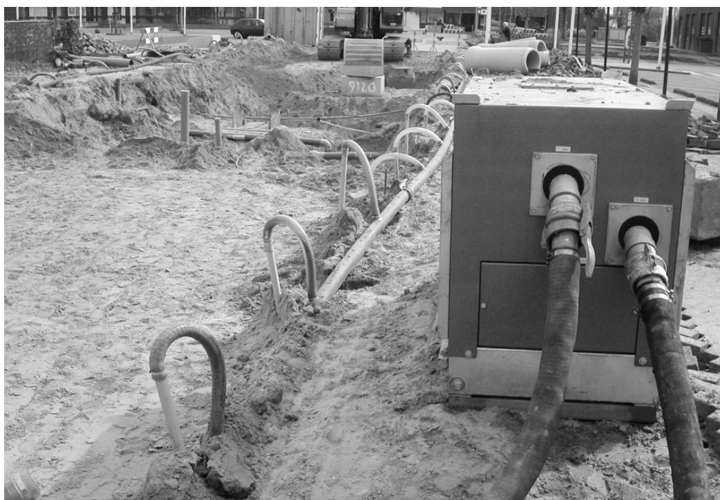
Figuur 6.58 geeft een foto van de bronbemaling met zuigerpomp.
