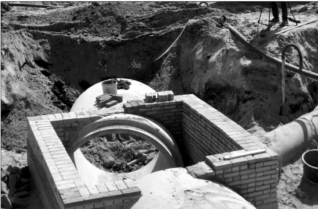
Figuur 6.11 Gemetselde rioolput [de Hamer]
