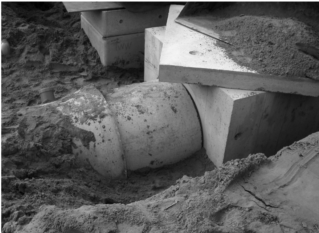
Figuur 6.14 Toepassing pasbuis bij aansluiting op rioolput
