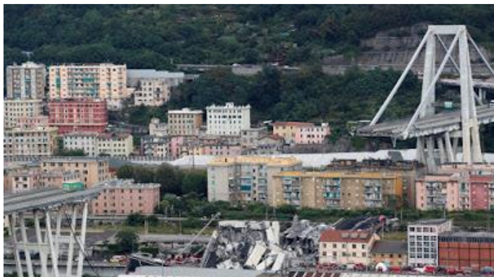
Figuur 18. Het ingestorte gedeelte met daaronder het puin van de brug. Foto: Eugenio Ceroni and Luca Cozzi, Ponte Morandi - Autopsia di una strage .
