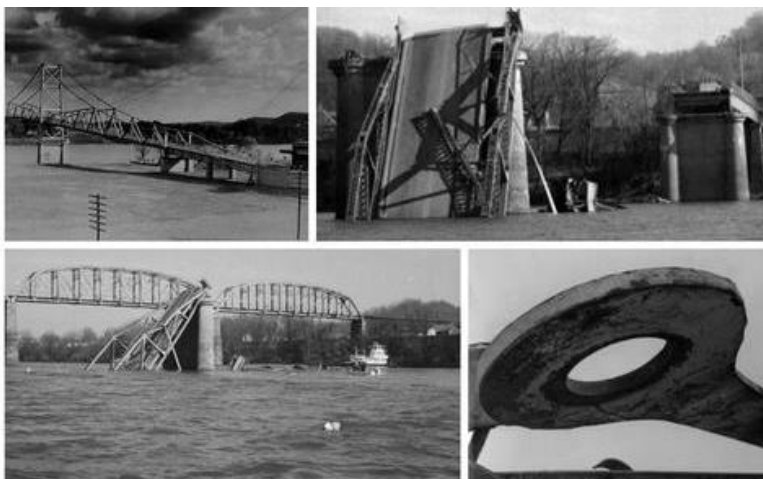
Figuur 9. De ravage na het ongeval van de Silver Bridge, foto's Public Domain.
