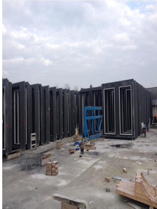
PUIEN EN PREFAB BETON
