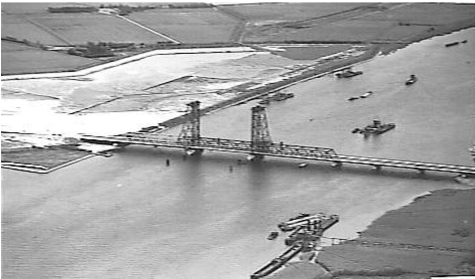
Huidige Botlekbrug tijdens de bouw in 1955
