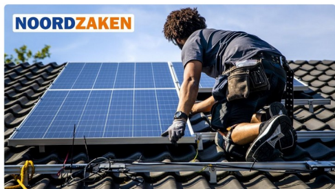
Een monteur legt zonnepanelen op een dak © ANP
