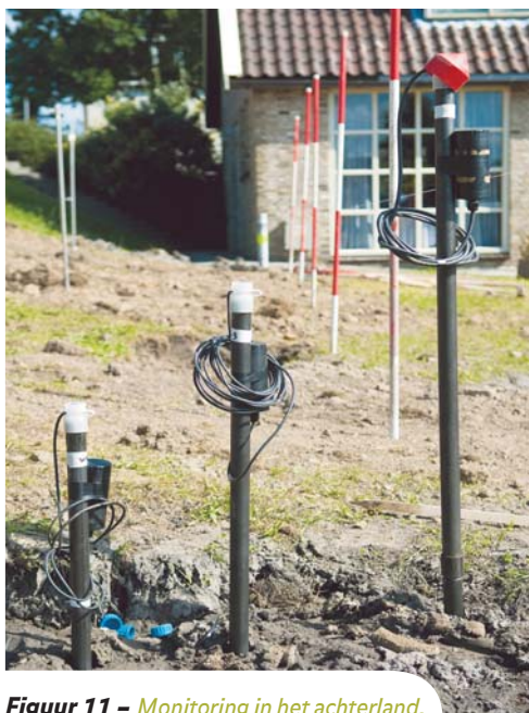
Figuur 11 – Monitoring in het achterland.
