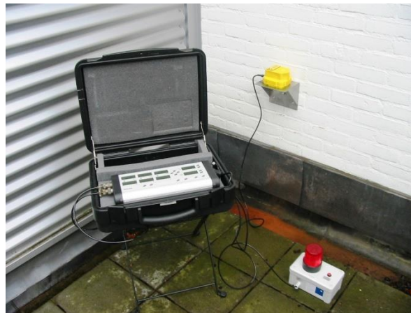
Figuur 8.12.4 Voorbeeld trillingsmeet apparatuur
