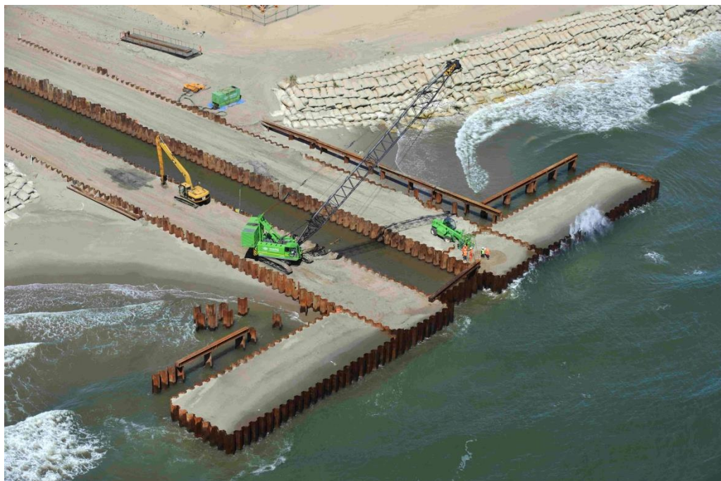
Figuur 5.4.14 Kofferdam voor het aanleggen van een pijpleiding; Russisch eiland Sachalin; (bron: Voorbij funderingstechniek)
