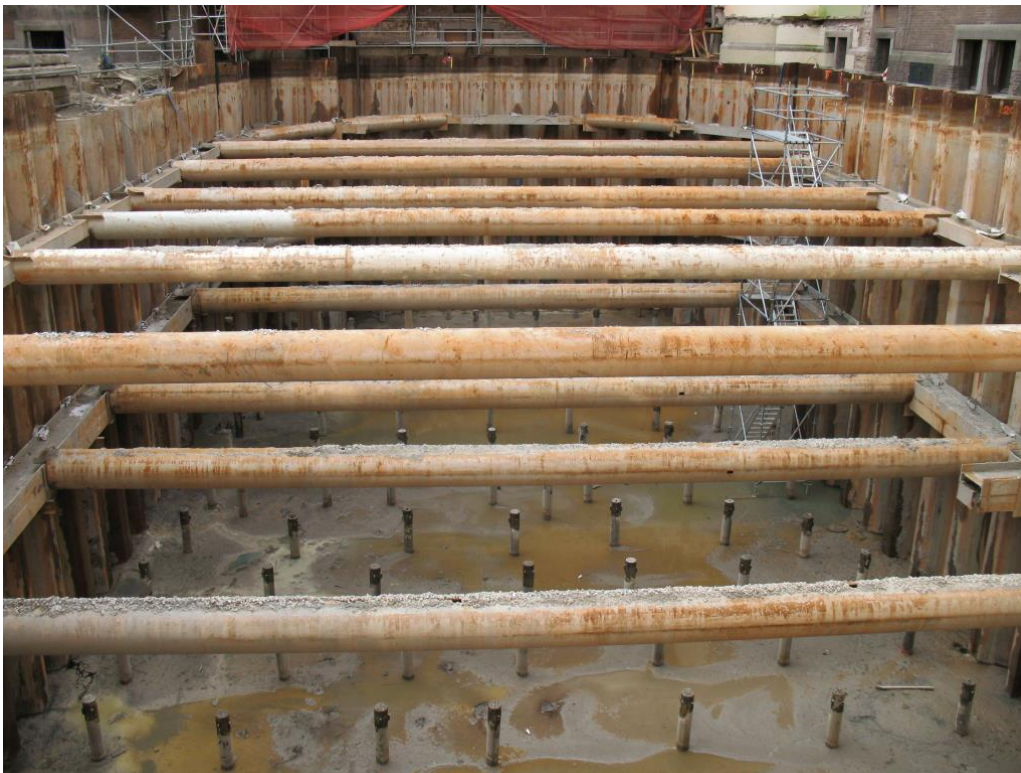
Figuur 8.9.1 Bouwkuip met stempelraam (Conservatoriumhotel Amsterdam; bron: CRUX Engineering)
