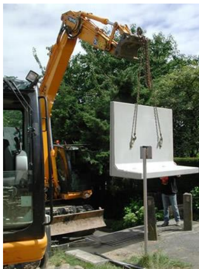
Figuur 5.2.2 Kleine L-wand – zonder uitsteek aan voorkant; (bron: Geomet)
