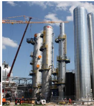
Bouw van CO 2 afvangst installatie
