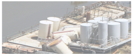
Voorbeeld van bezrijven: Olieopslagtank drijft op van fundering en zorgt voor milieuschade in de omgeving vanwege lekkage van olie uit tank. Reparatiekosten veel geld en maanden werk.
