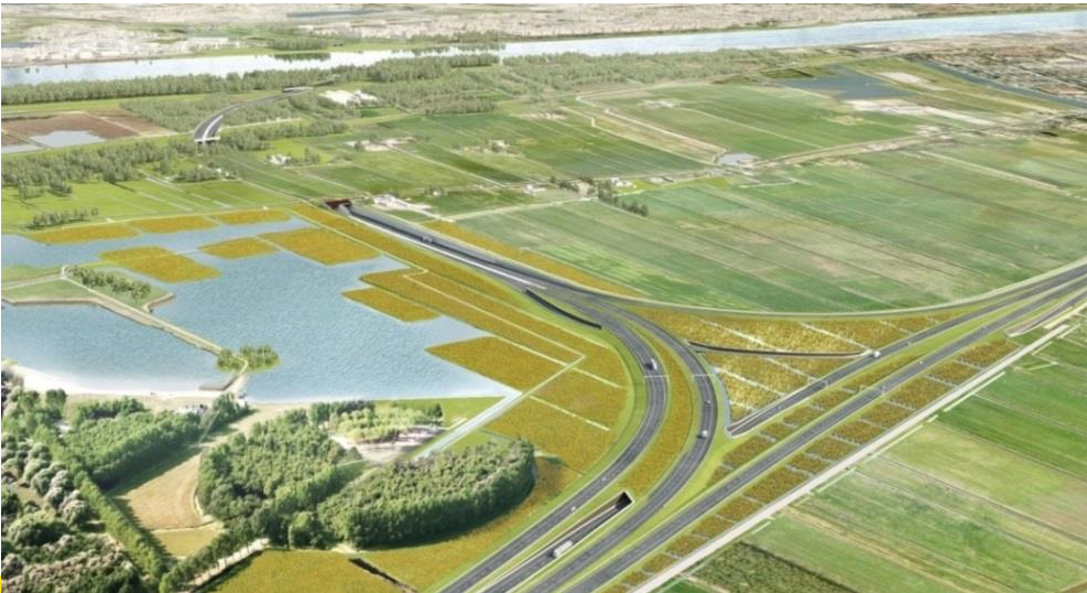
Noordoever, knooppunt A20/A24, ingang Aalkeettunnel
