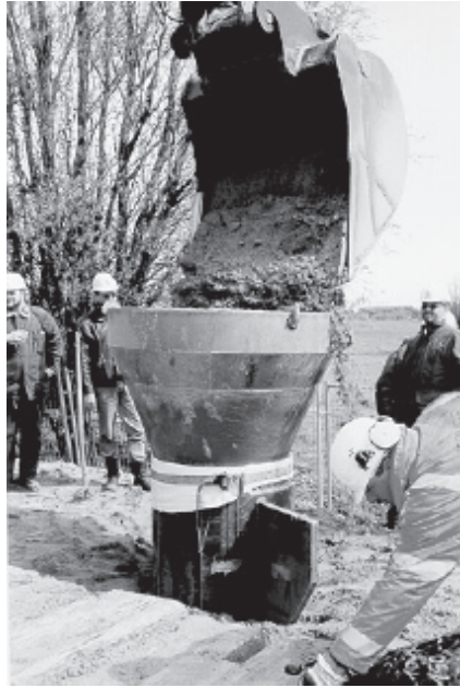
Figuur 14.1b Aanbrengen geokunststof omhulde zandpaal (proefvak Wijngaarden)
