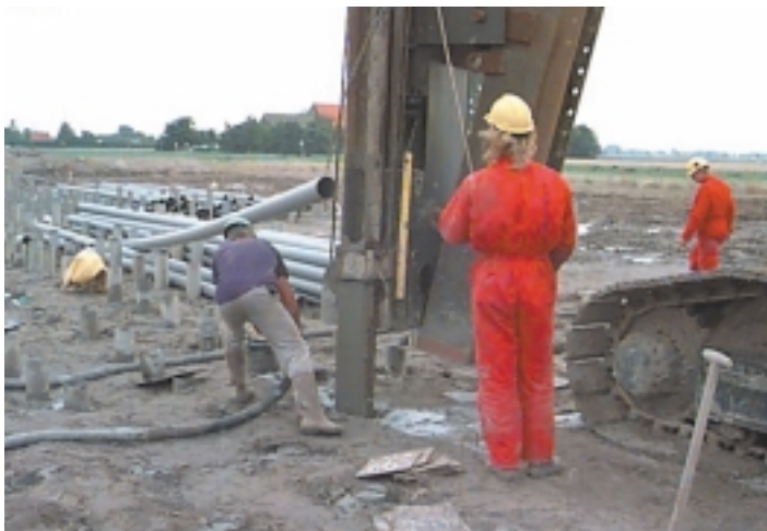
Installeren schuimbetonpalen
