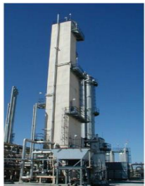
Small liquefaction Bio LNG
