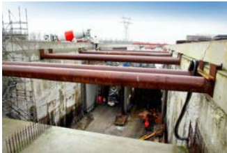
Stempels houden de wanden van de bouwkuip op hun plaats. (Foto: RWS Beeldbank/Ton Poortvliet)
