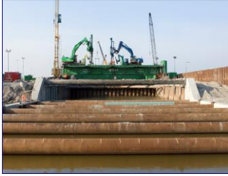
Type A spoelboren met dubbele buis
