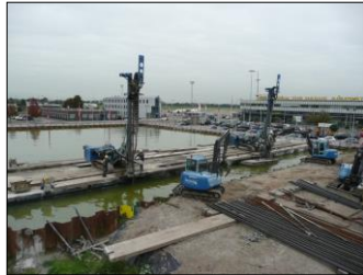
Type C zelfborende ankerpalen
