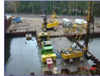
Type D geschroefde ankerpalen
