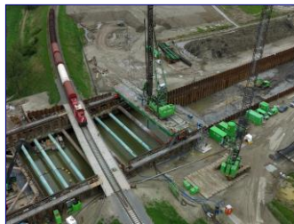
Type E getrilde ankerpalen
