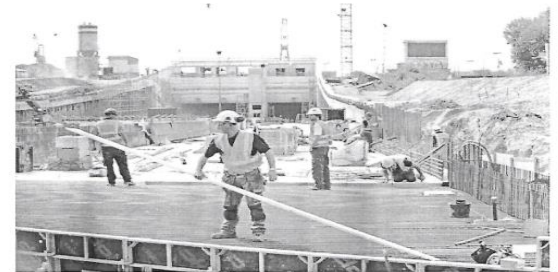
Nederland, Amsterdam, 26 april 2017. Bouwplaats van de tweede Coertunnel. De aanbouw aan de noordelijke ingang nadert de voltooiing. Links de ventilatievoorziening van de (eerste) Coertunnel. Foto: Co de Kraker/H&M.
