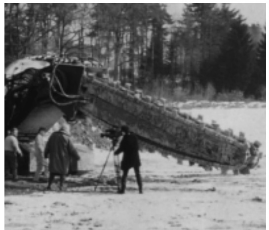
2c Freesmenginjectie-machine voor vervaardiging van blokstabilisaties
