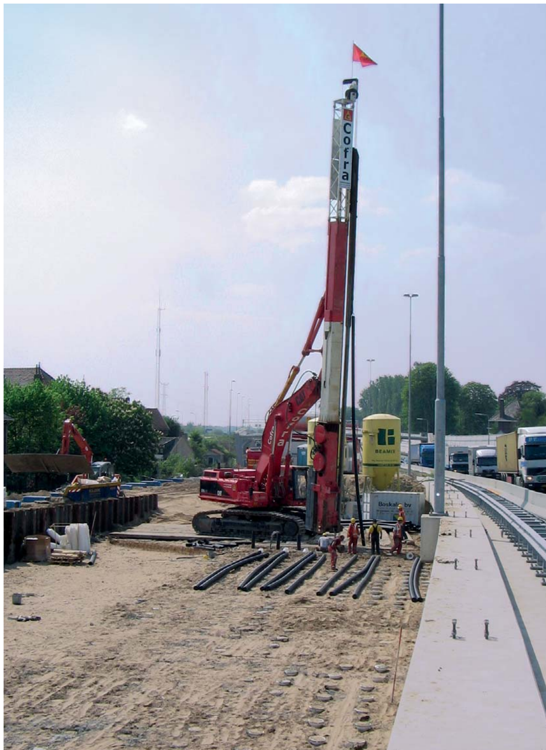
Foto 1 Paalmatras met AuGeo palen A15.
