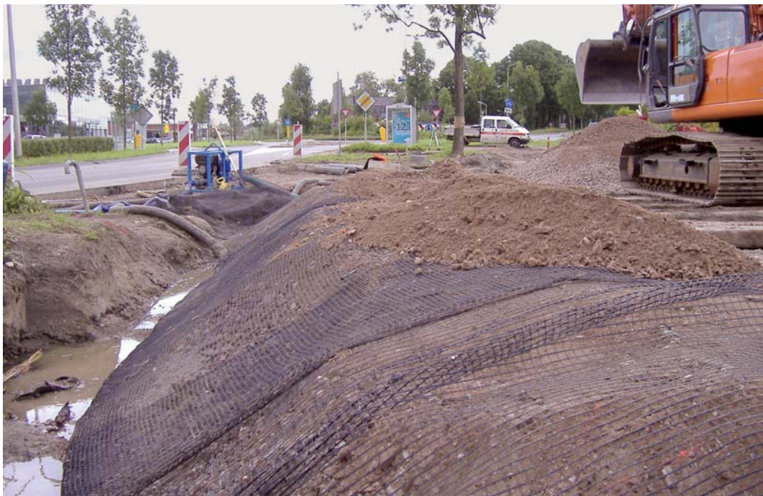
Foto 3 Geogrid wapening paalmatras zuidelingsdijk Gorinchem.
