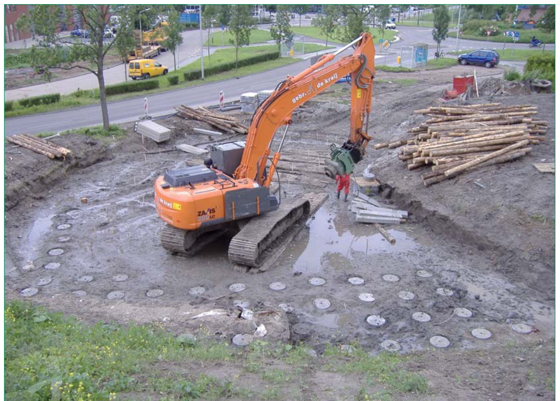
Foto 2 Houten palen voor paalmatras Zuidelingsdijk Gorinchem.
