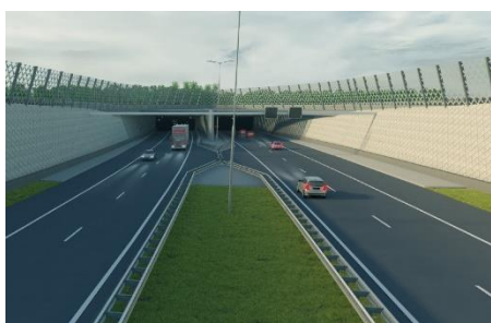
Foto's: Rottemeren tunnel
