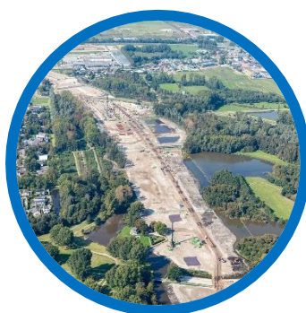
Foto's: Rottemeren tunnel
