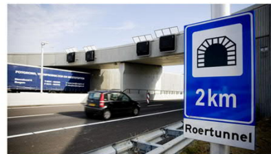
De in 2010 geopende Roertunnel kreeg een 'zeer goed' als beoordeling. BEELD AN/P
