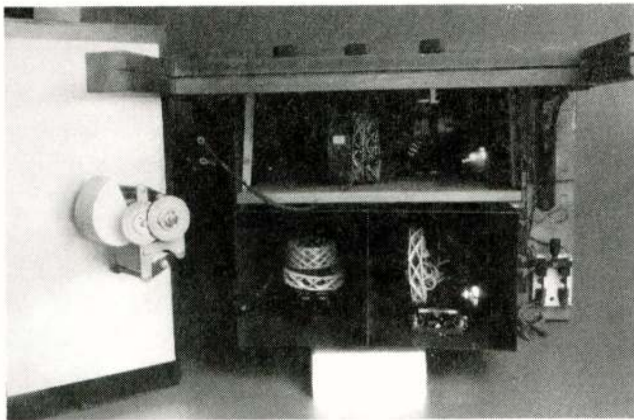
Toongenerator volgens principe waarnaar Philips later de zwevings-toongenerator maakte. Geconstrueerd door Prof. ir. Huydts, 1930
