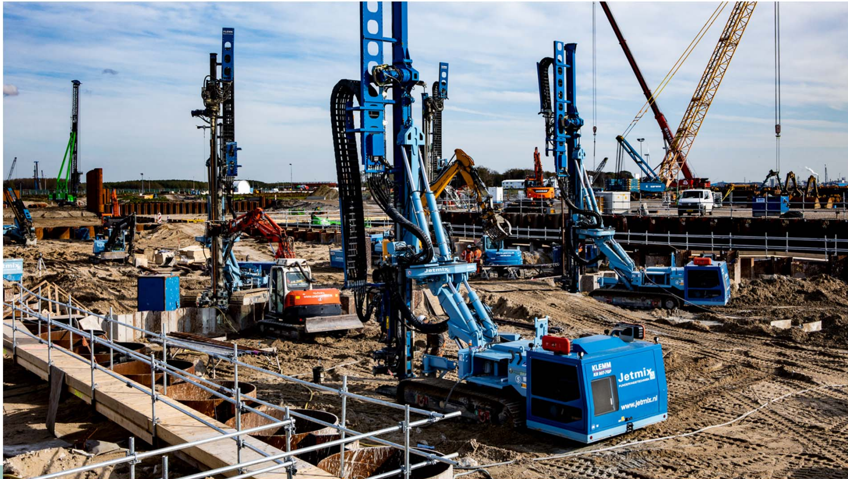
Maasdeltatunnel in uitvoering
