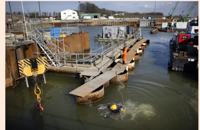
Dulkers zijn volop bezig met werkzaamheden in de grond, ter voorbereiding op de tunnelbak. Foto: Ramon van Flymen voor het FD
