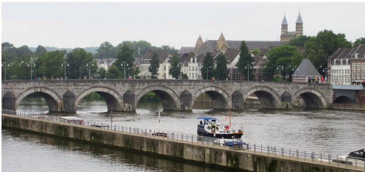
Sint Servaasbrug, Maastricht
