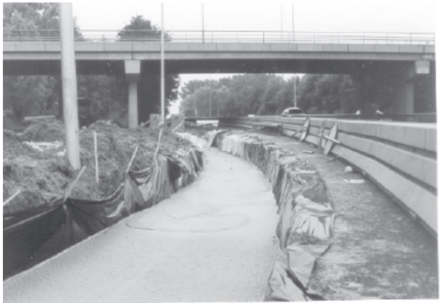
Figuur 5.1b Aanbrengen schuimbeton ophoging voor wegverbreding (uit [8])
