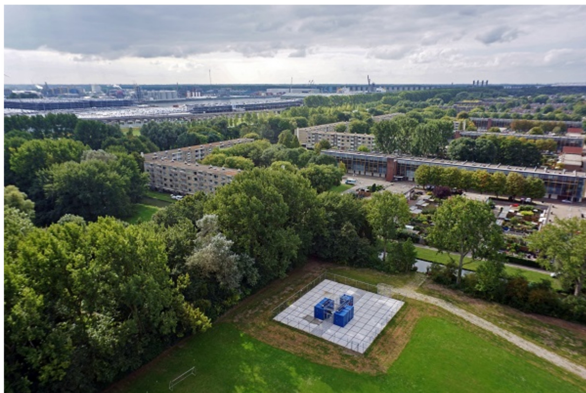
Power2Gas-installatie in Rozenburg met de waterstofinstallatie (blauwe containers) en het appartementencomplex (links midden) dat begin 2019 met waterstof wordt verwarmd. FOTO: DNV GL
