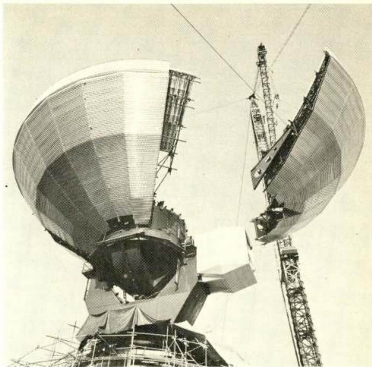
Fig. 1. Montage van de parabolische spiegel van Raisting III.
