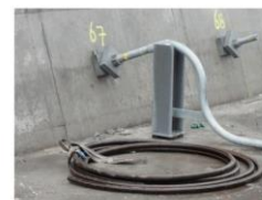
Figuur 3. Voorbeeld beschermingsconstructie voor de overgang van de reboortoren van het anker naar de ontluchter
