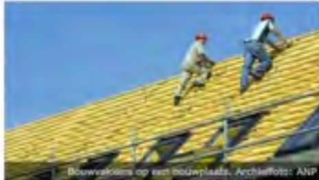
Bouwvakkers op een dakvloer. Archief foto: ANP
