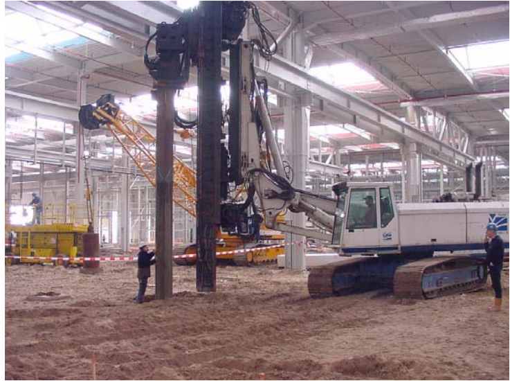
Figuur 8b : Trilverdichten
