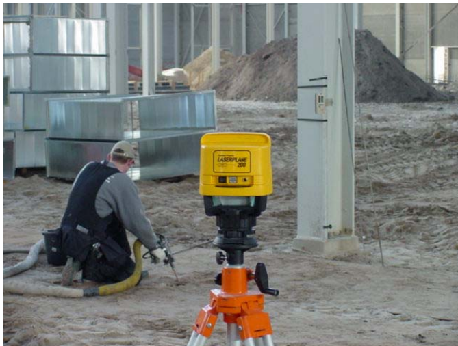
Figuur 4 : polyurethaaninjectie en laserverklikker
