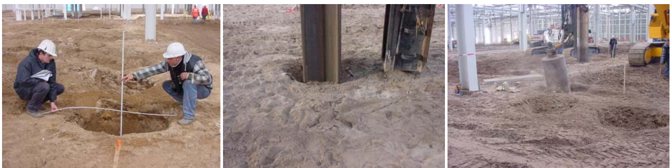
Figuren 11 a t/m 11c : Verdichtingskraters
