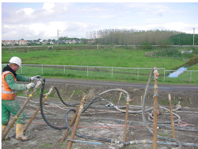
Figuur 7. Het vullen van de kousen. De grout wordt aangevoerd door aan de injectiebuizen aangesloten slangen.
