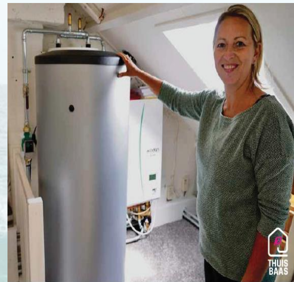
Binnen-unit lucht-water warmtepomp
