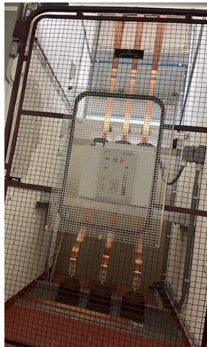
10kV Midden spanning installaties
