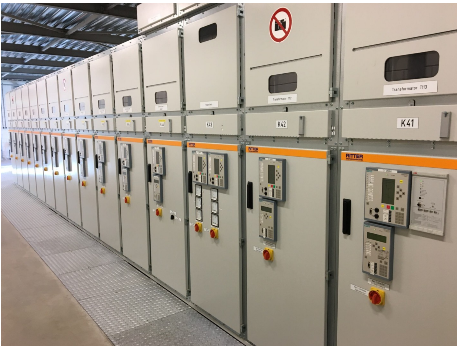
10kV Midden spanning installaties
